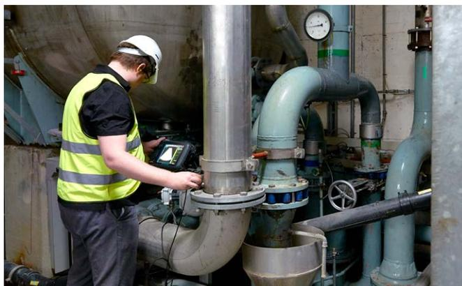
Инспекция промышленного трубопровода с помощью дефектоскопа Proceq Flaw Detector 100
